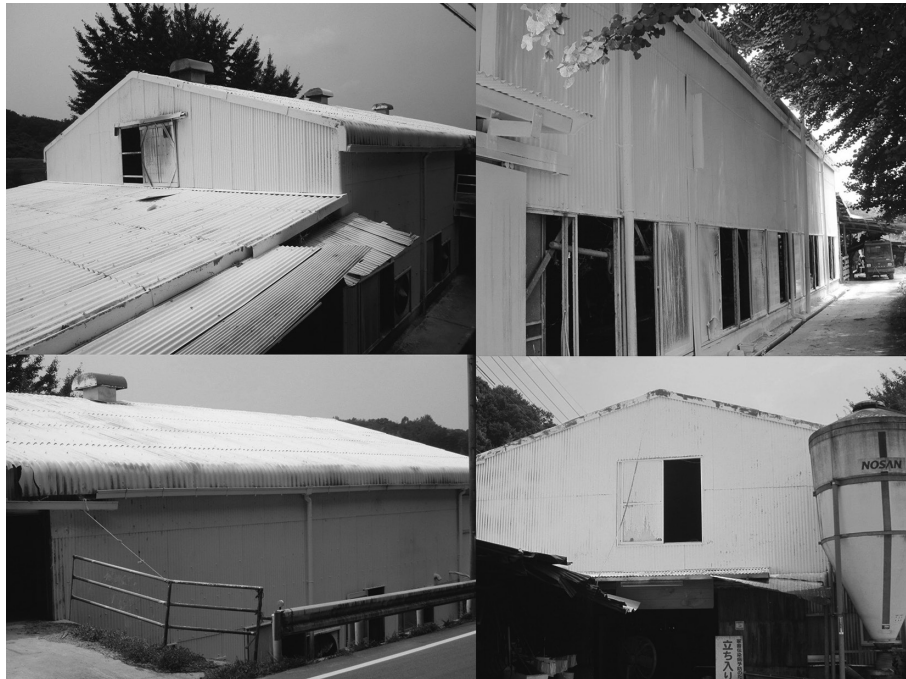
写真 3 ドロマイト石灰乳の塗布 (屋根と壁面)
