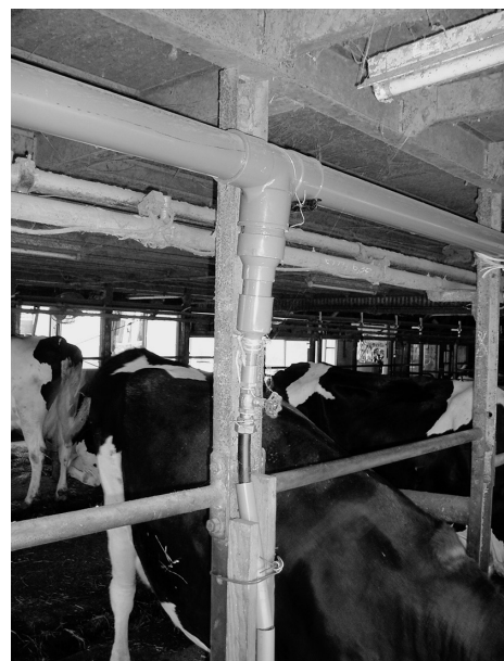
写真 12 給水主配管のインチアップ (75 mm 径)
