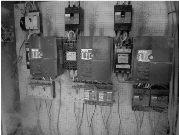
写真 9 複数の小型インバータで制御し故障リスクに備える
